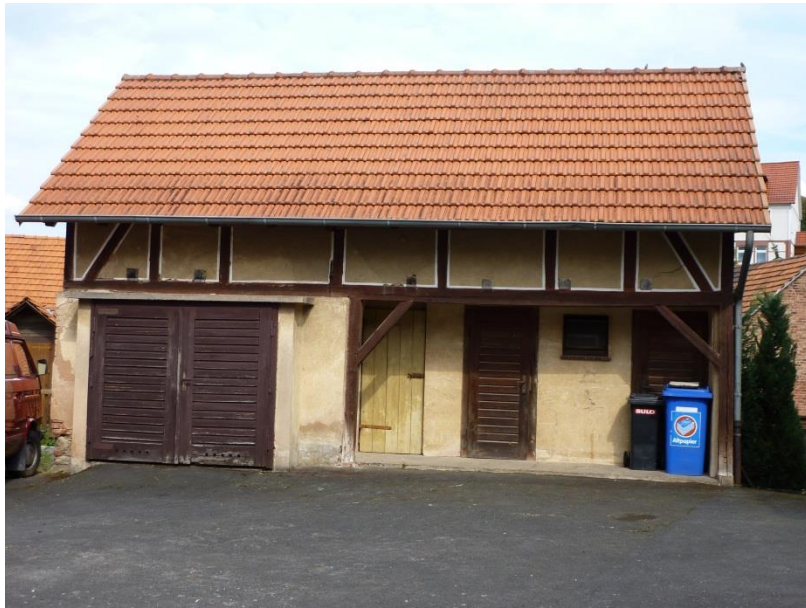
Wirtschaftsgebäude vor Renovierung
