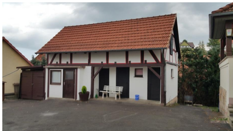
Wirtschaftsgebäude nach Renovierung, jetzt Jugendraum
