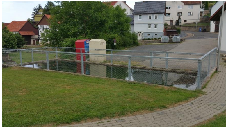
Neue, sichere Umzäunung um Feuerlöschteich
