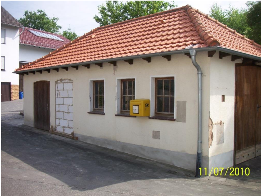
Spritzenhäuschen vor Renovierung
