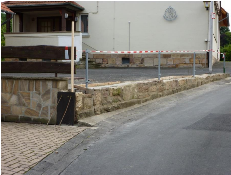
Neue Mauer vor DGH
