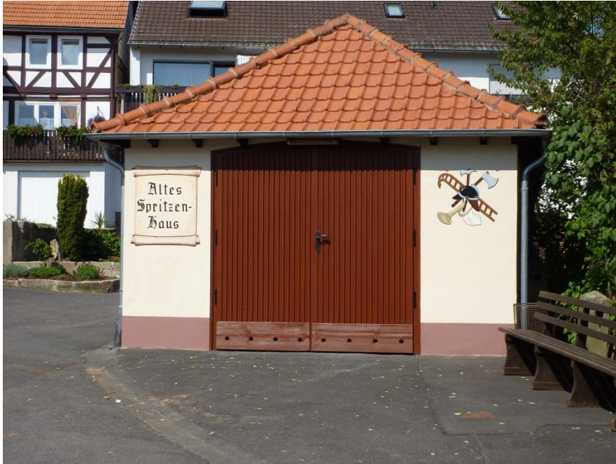
Altes Spritzenhäuschen nach Renovierung
