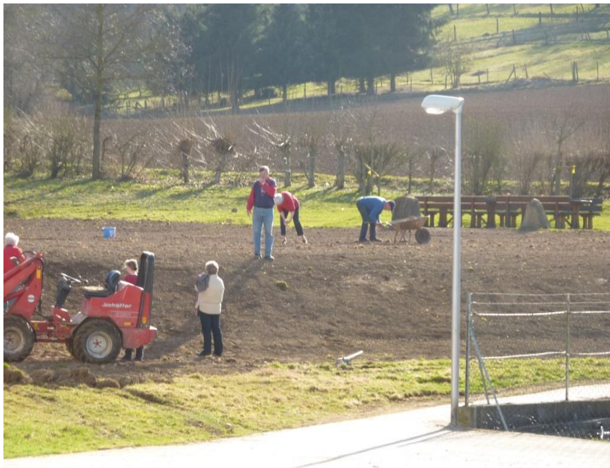
Baumaßnahmen am Gelände
