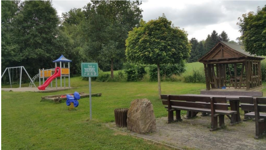
Spielplatz auf Multifunktionsfläche nach Fertigstellung
